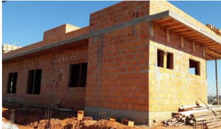
Figura 3 - Residência uni familiar em alvenaria estrutural
