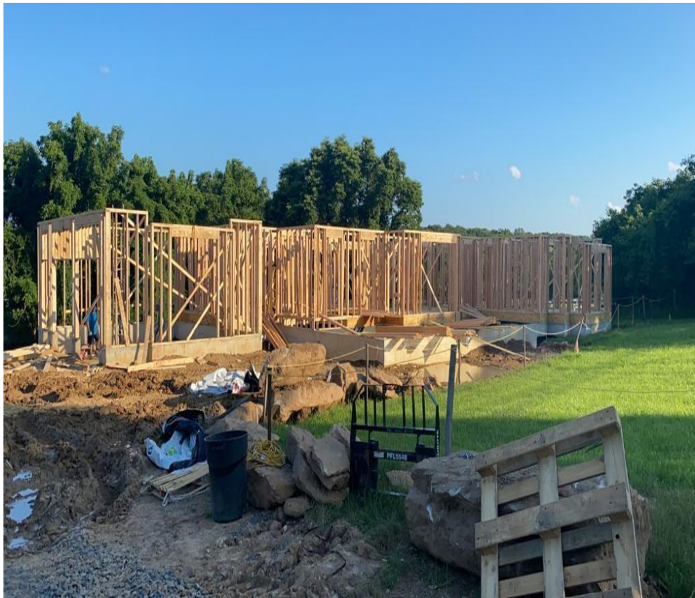
Figura 13 - estrutura da residência concluída
