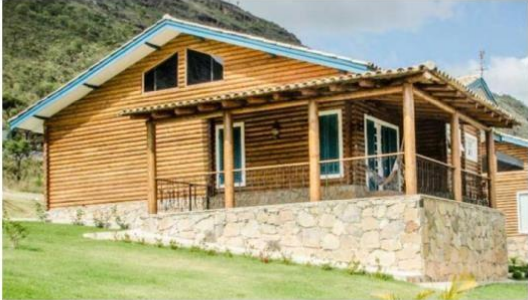
Figura 6 - Wood frame construída no sul do Brasil
