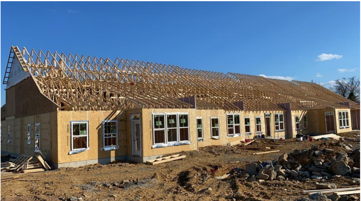
Figura 17 - construção de casas geminadas
