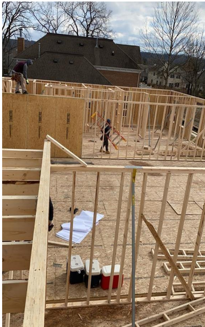
Figura 10 – obra 1º andar
