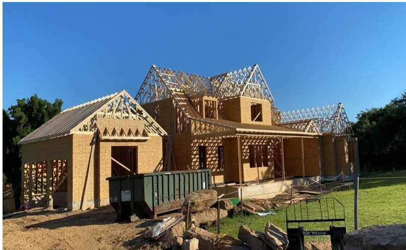
Figura 14 - construção em madeira
