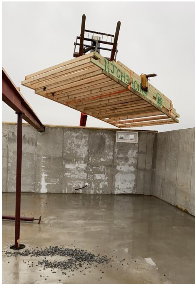
Figura 9 - Porão finalizado inserção da base da casa
