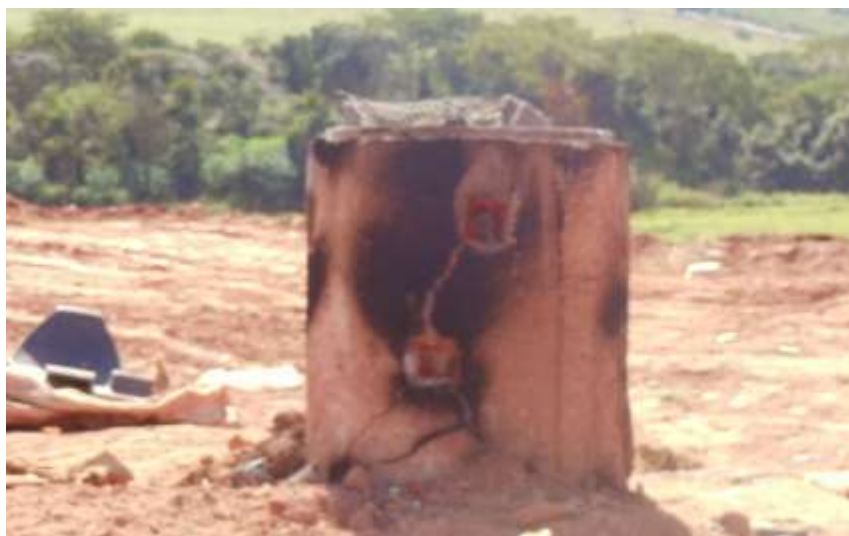
Figura 21 – Queima do biogás.
