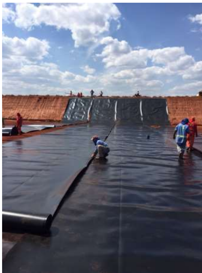
Figura 13 – Preparação do ambiente para destinação dos resíduos
