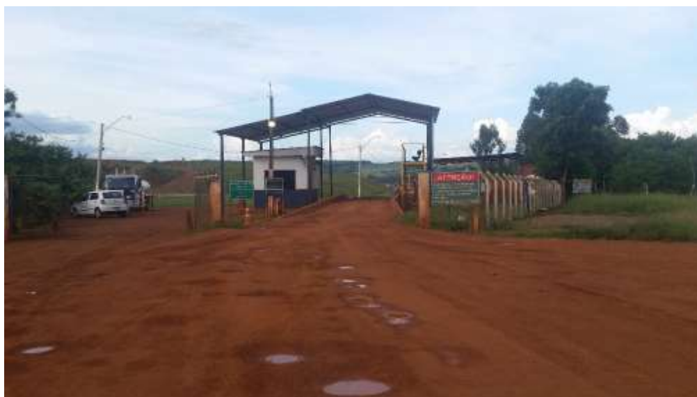
Figura 09 – Portaria do Aterro Sanitário Municipal de Anápolis.
