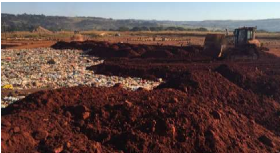
Figura 18 - Recobrimento dos resíduos compactados.
