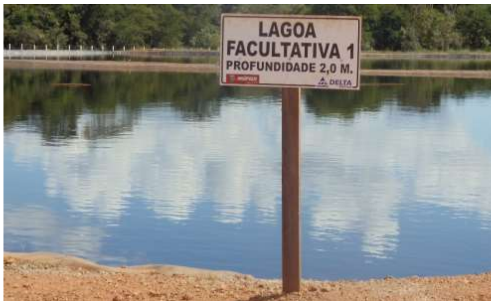
Figura 20 - Lagoa facultativa do Aterro Sanitário Municipal de Anápolis.
