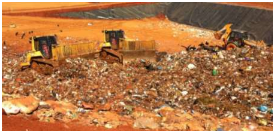
Figura 17 - Espalhamento e compactação de resíduos.
