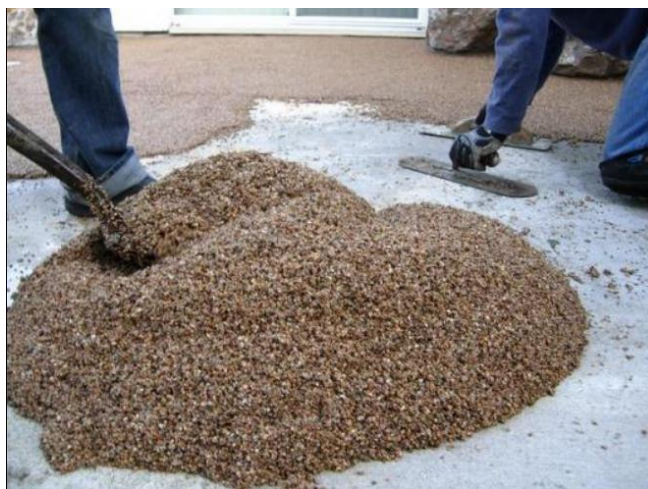
Figura 06 - Colocação dos grãos de granitina na massa.
