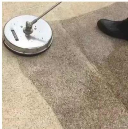
Figura 09 - Polimento da superfície.
