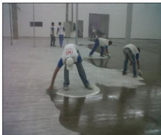
Figura 10 - Aplicação da resina.
