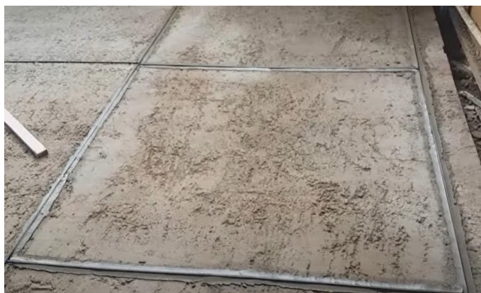
Figura 03 - Fixação das juntas de dilatação.
