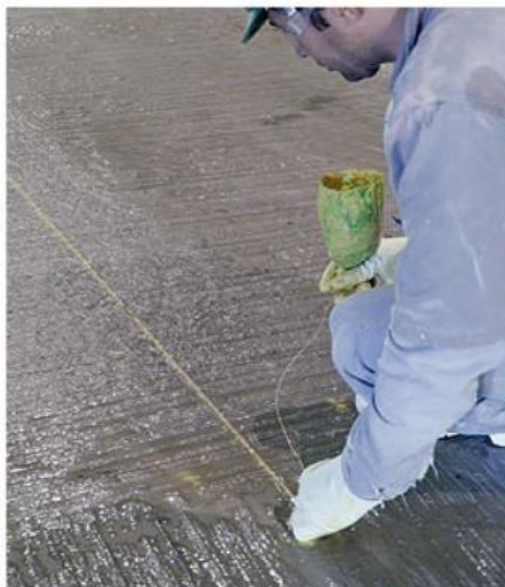
Figura 02 - Marcação do contrapiso.
