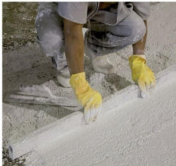
Figura 05 - Sarrafeamento da argamassa.
