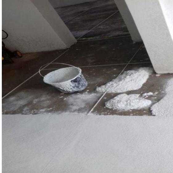
Figura 04 - Aplicação da argamassa de cimento.
