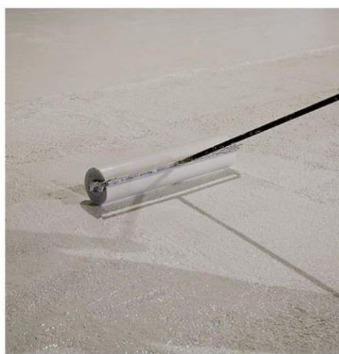
Figura 08 - Compactação da superfície
