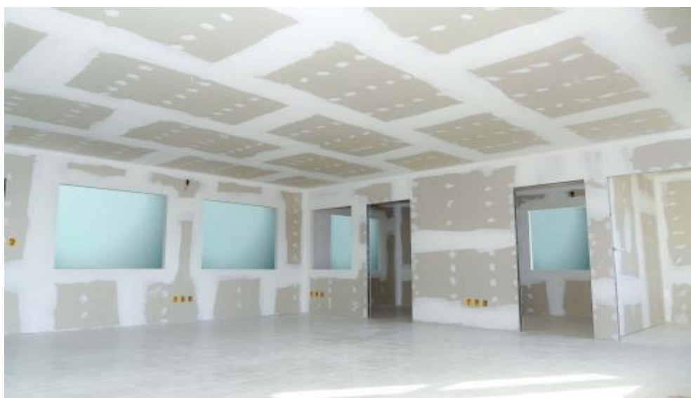
Figura 3 - Construção em drywall
