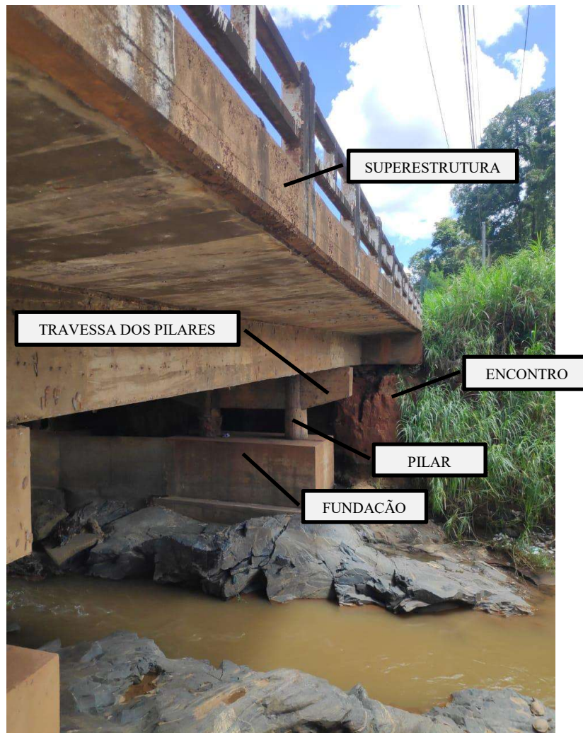
Figura 21 – Elementos estruturais da Ponte Sobre o Rio das Antas
