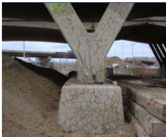
Figura 10 – Reação álcali-agregado
