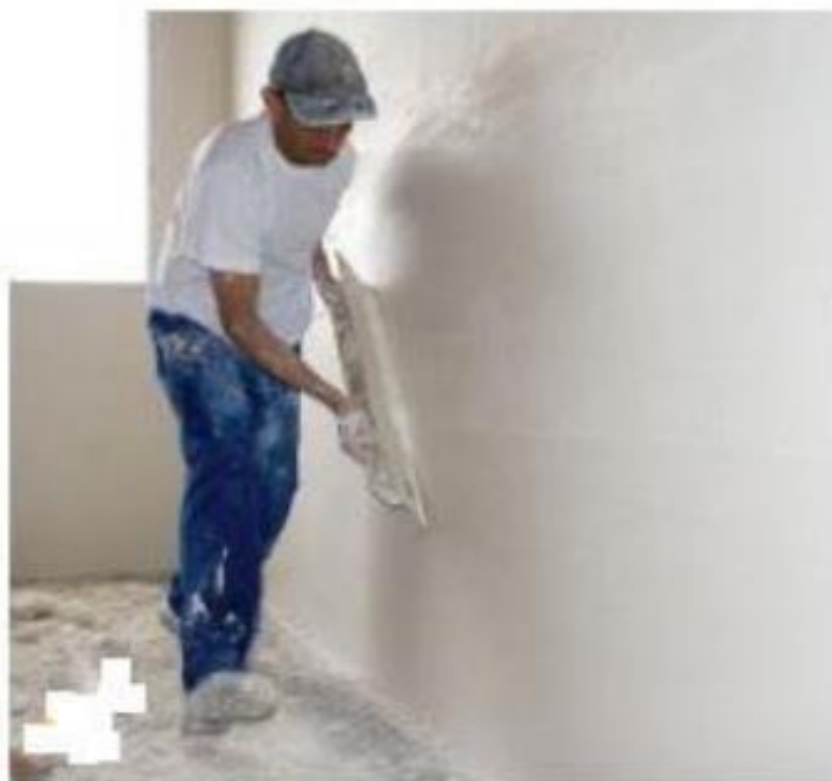
Figura 2 - Revestimento de gesso utilizando a desempenadeira.
