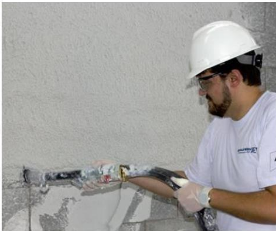
Figura 4 – Execução de gesso projetado.
