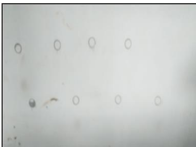
3 - PAREDE APÓS EXECUÇÃO / BLOCO 02 - APARTAMENTO 104 - SALA
