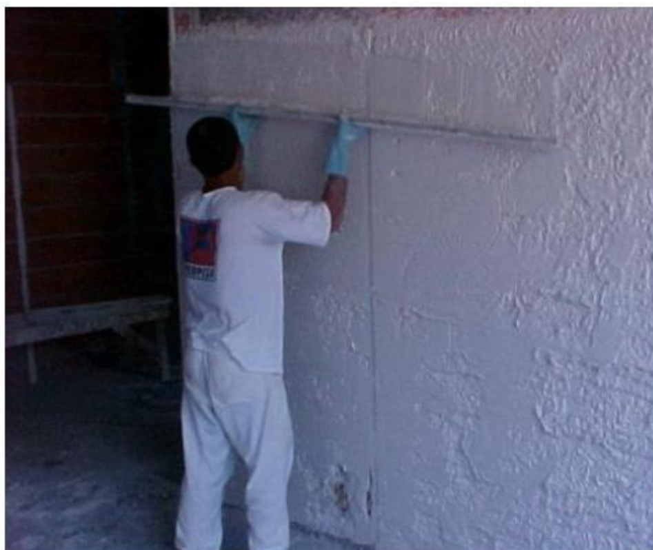
Figura 3 - Execução de revestimento de gesso sarrafeado.
