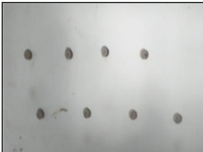
1 - PLASTILHAS COLADAS PARA EXECUÇÃO DO ENSAIO / BLOCO 02 - APARTAMENTO 104 - SALA
