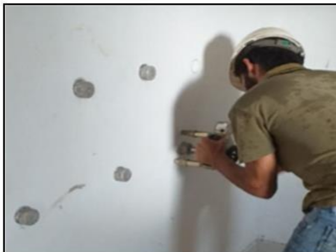
2 - EXECUÇÃO DO ENSAIO / BLOCO 02 - APARTAMENTO 104 - SALA
