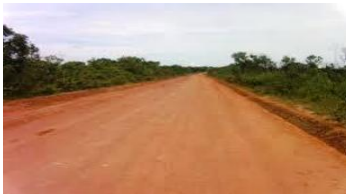
Figura 6 – Estrada não pavimentada
