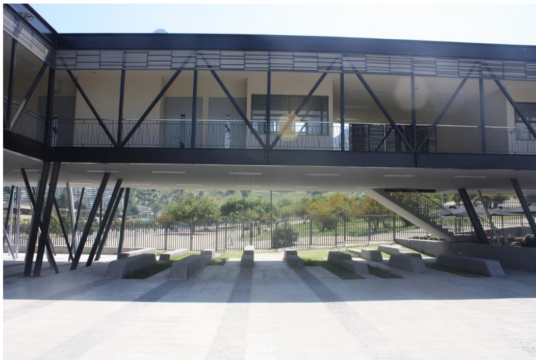
Figura 5 – Viga do Centro Cultural El Tanque
