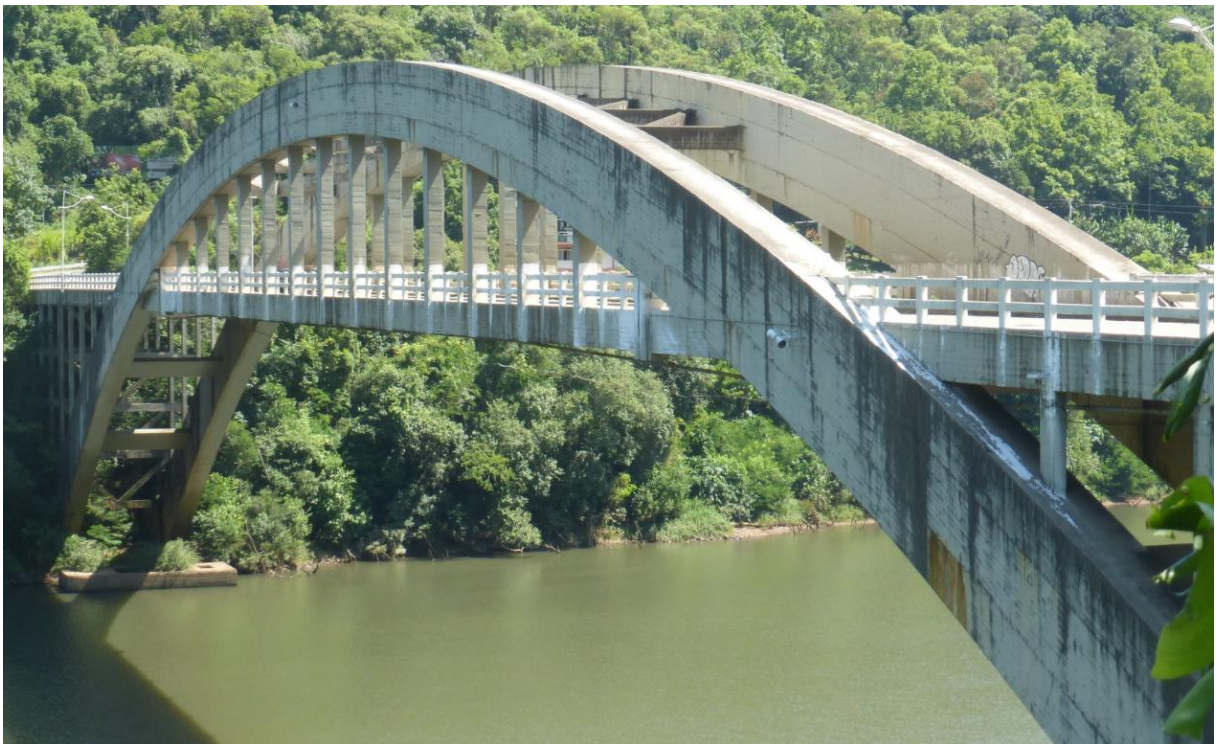
Figura 7 – Ponte Ernesto Dornelles
