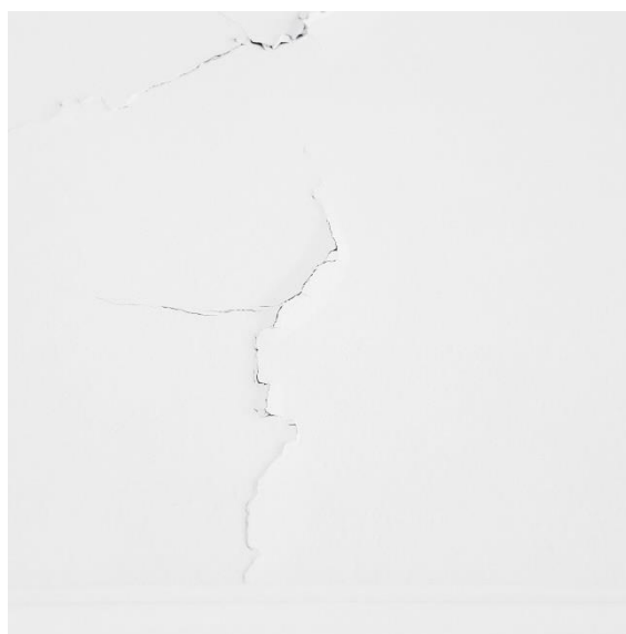
Figura 1 Fissuração por Recalque de Fundação
