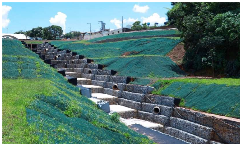
Figura 15 – Gabião construído na Vila Formosa
