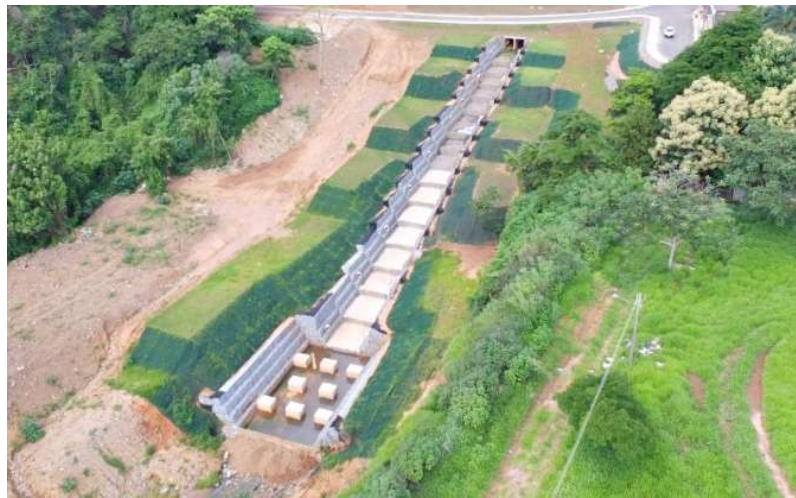
Figura 14 – Obra de recuperação da Vila Formosa
