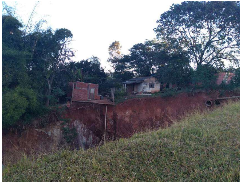
Figura 12 – Casa localizada ao lado da erosão.
