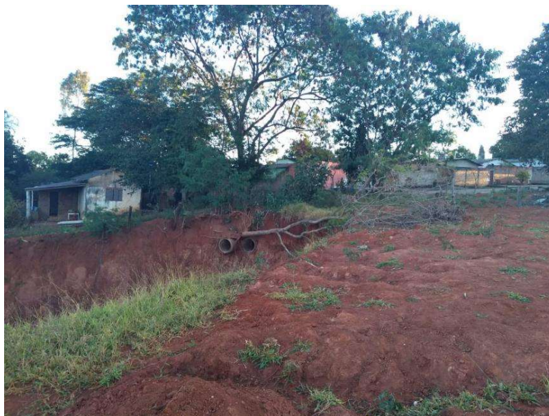
Figura 13– Arvore que foi derrubada pelo deslizamento de terra.
