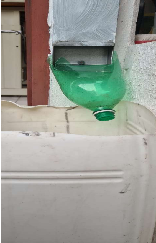
Figura 7 - Reservatório da residência onde a amostra foi coletada
