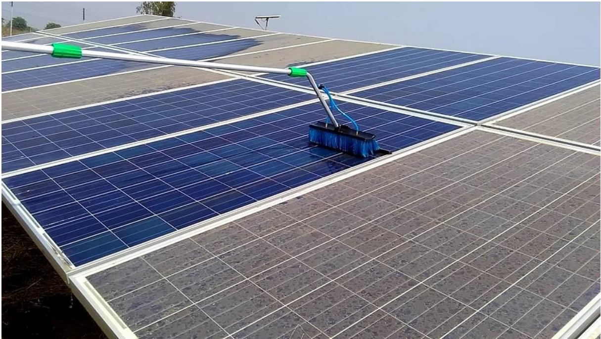
Figura 49 - Limpeza do módulo fotovoltaico.
