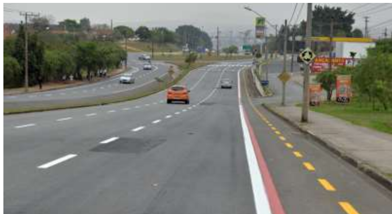
Figura 29 - Avenida com sinalização horizontal bem definida
