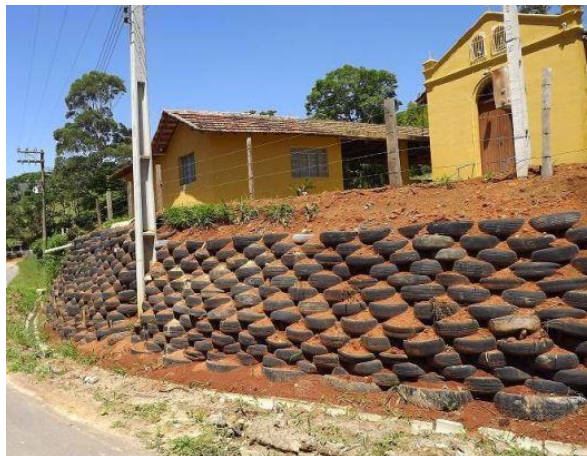
Figura 3 - Pneu em obra de contenção de encosta
