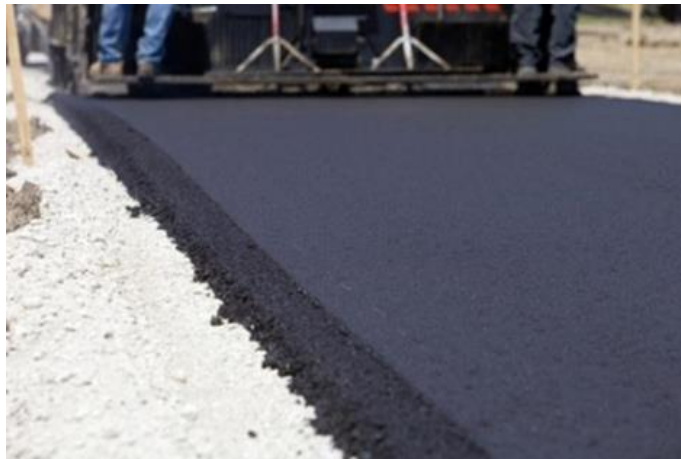
Figura 6 - Pavimentação asfáltica com pneu
