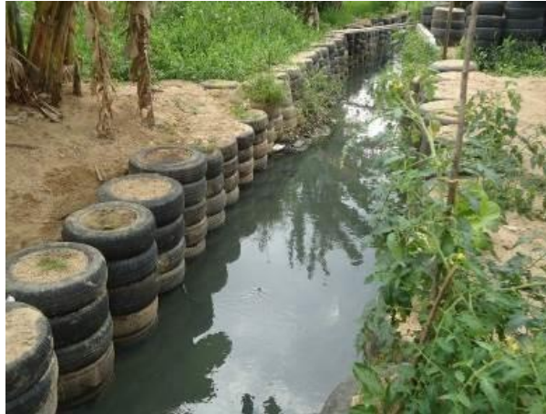
Figura 2 – Pneus utilizados como obra de drenagem
