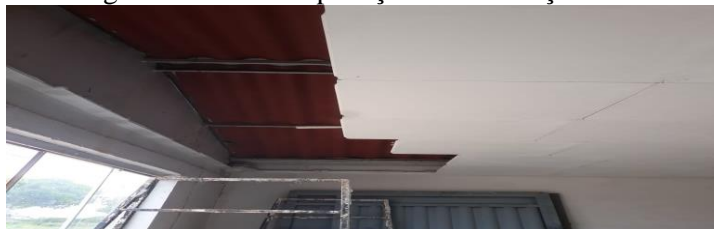
Figura 6- Local de aplicação na construção civil
