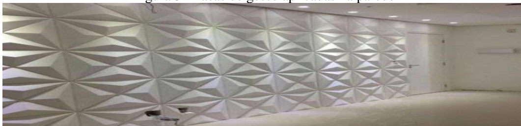
Figura 3–Placas de gesso aplicadas na parede
