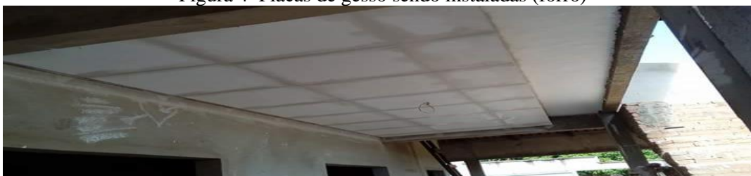
Figura 4–Placas de gesso sendo instaladas (forro)
