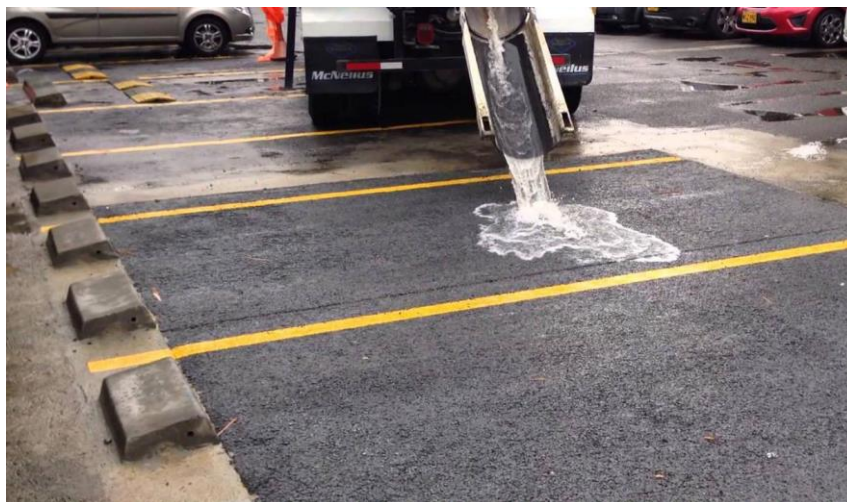
Figura 2 – Concreto permeável aplicado no pavimento de um estacionamento.
