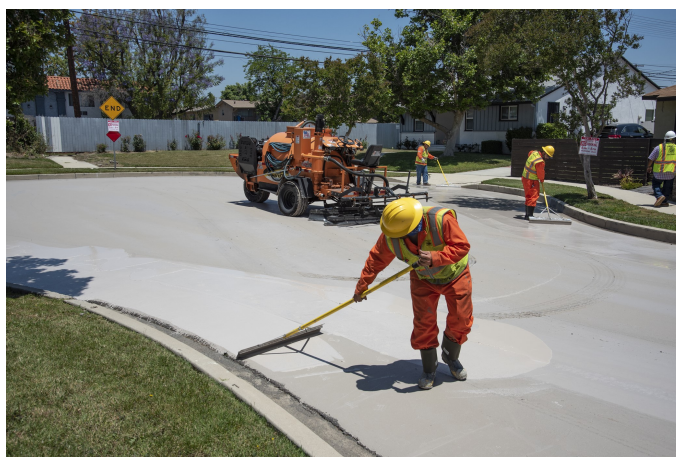
Figura 6 – Execução de tratamento térmico sobre um trecho de asfalto na cidade de Los Angeles.
