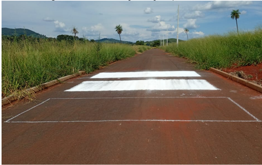
Figura 4 – Pavimento após a aplicação das tintas.
