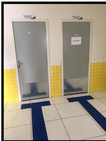
Figura 03- Acesso aos banheiros exclusivos para cadeirantes
