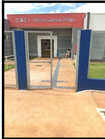
Figura 02 – Portão da Entrada principal do CMEI
