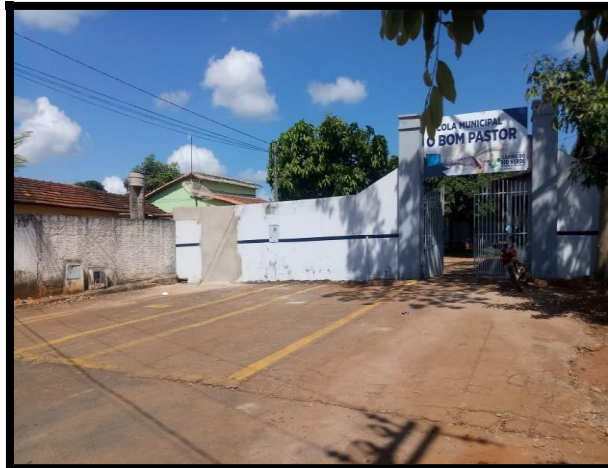
Figura 09 – Entrada principal da Escola
