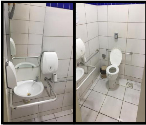
Figura 04 – Imagens interna do banheiro para cadeirante
