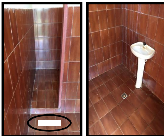
Figura 30 – Imagens internas do banheiro feminino
