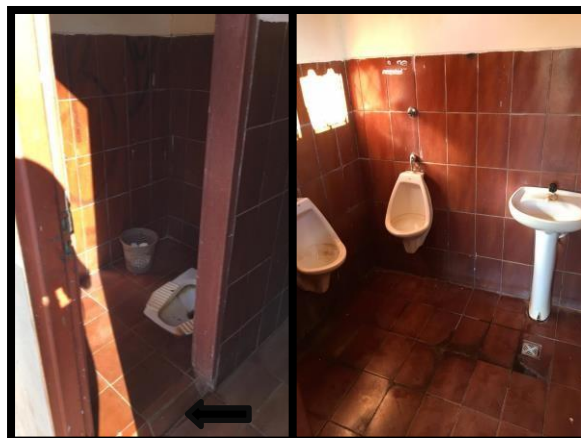
Figura 31 – Imagens internas do banheiro masculino
