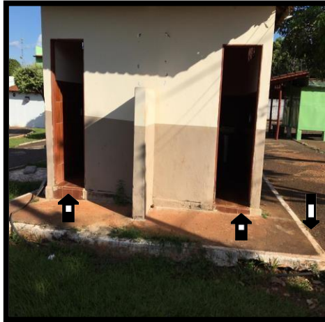
Figura 29 – Imagem externa do banheiro
