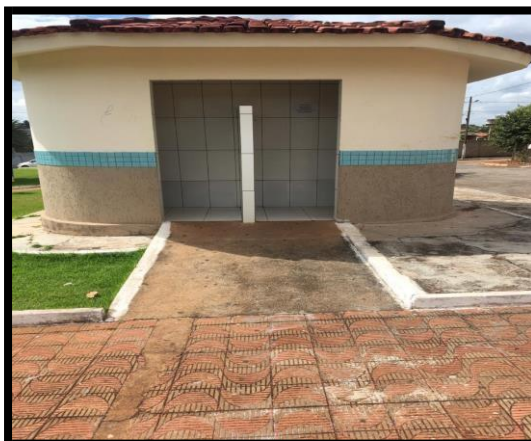
Figura 24 – Imagem externa do banheiro
