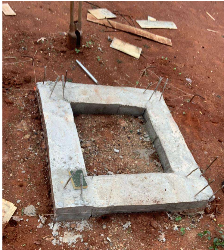
Figura 3.8 – Fabricação das vigas baldrame.
