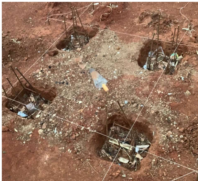
Figura 3.6 – Escavação dos blocos.
