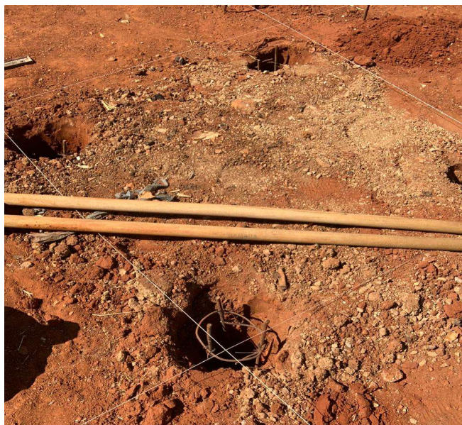
Figura 3.4 – Escavação do terreno e alocação da armadura.
