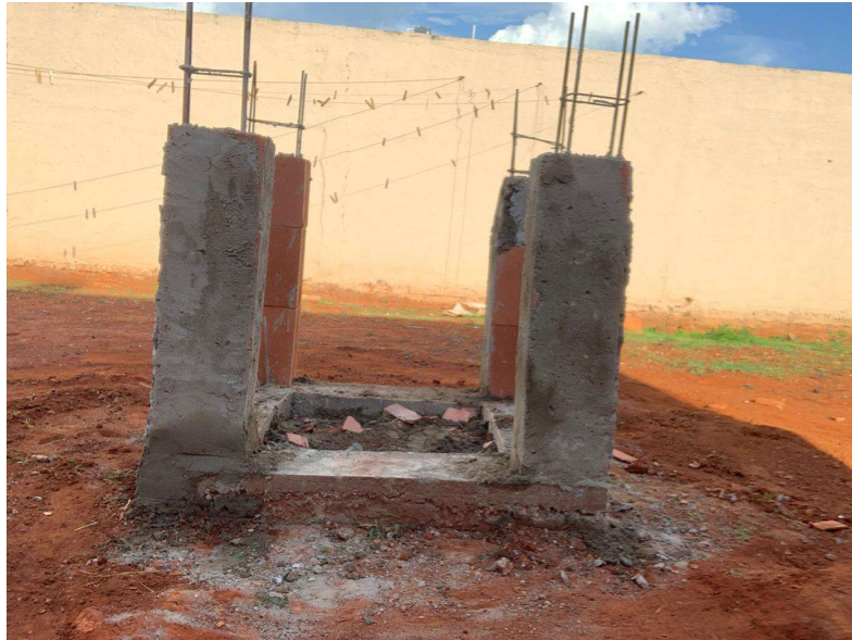
Figura 3.9 – Fabricação dos pilares.
