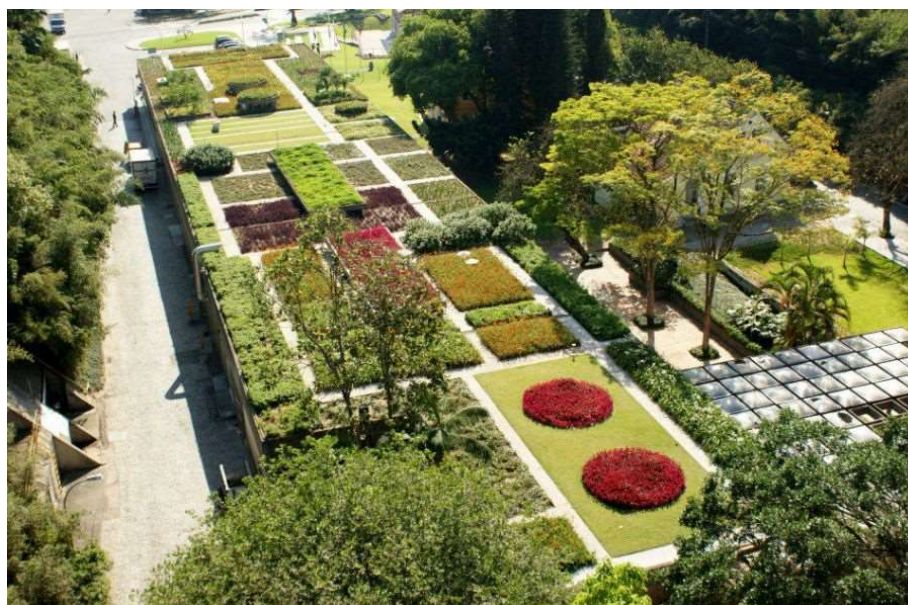
Figura 2.3 – Tipo de Telhado Verde intensivo:
