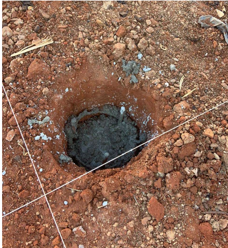
Figura 3.5 – Concretagem da fundação dos pilares.
