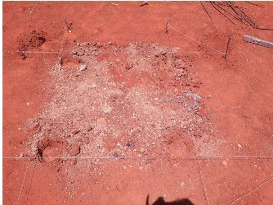
Figura 3.3 – Marcação do terreno.
