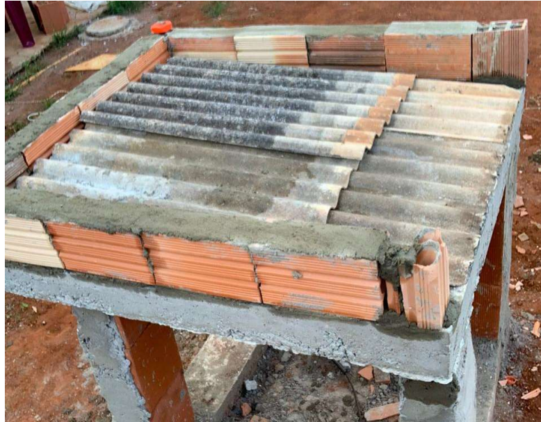
Figura 3.13 – Fabricação das vigas baldrame.
