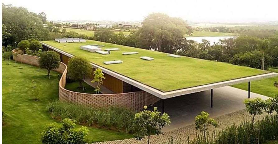
Figura 2.2 – Tipo de Telhado Verde Extensivo.
