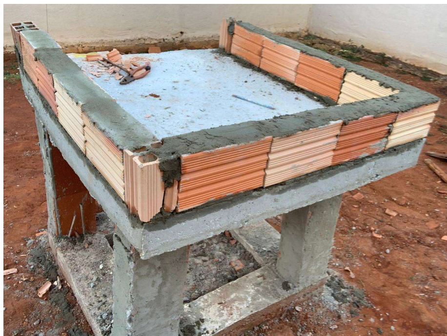
Figura 3.12 – Fabricação da Platibanda.
