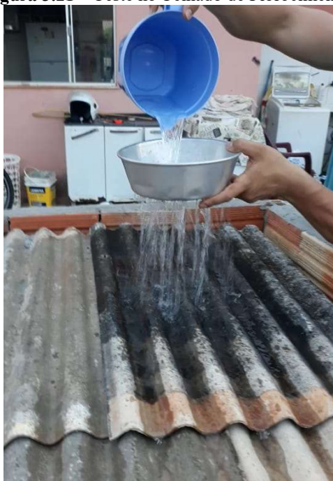
Figura 3.21 – Teste no Telhado de Fibrocimento.
