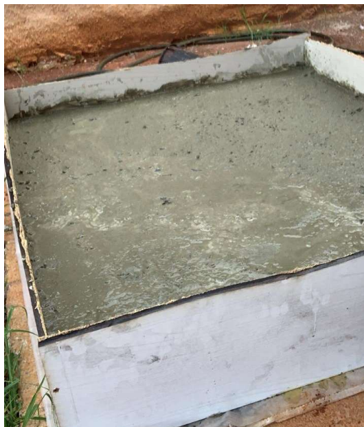
Figura 3.10 – Fabricação da laje.
