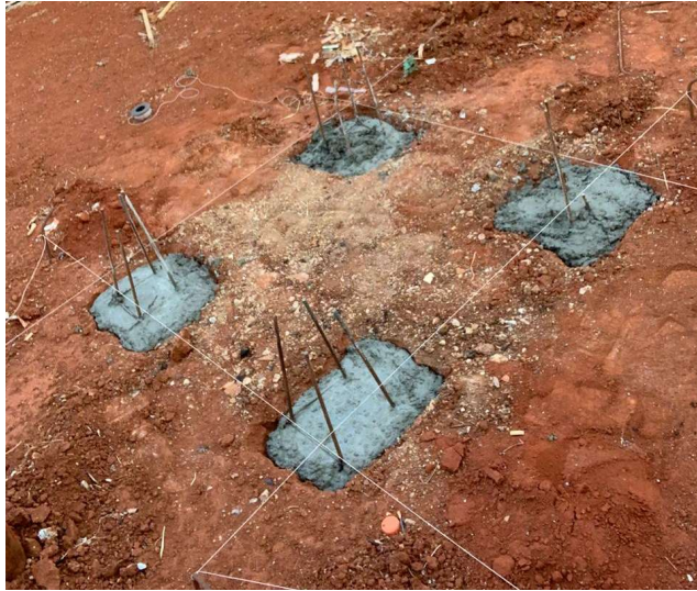
Figura 3.7 – Concretagem dos blocos.
