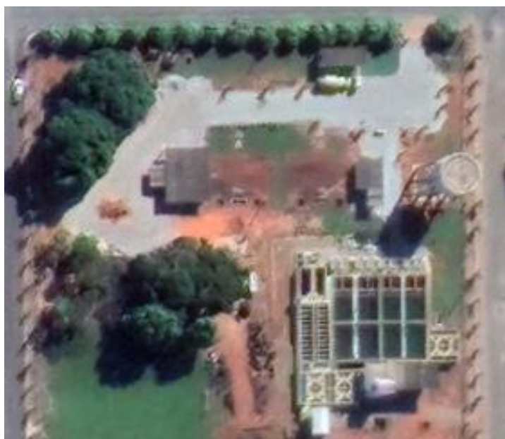
Figura 5 – Estação de tratamento de água de Goianésia-GO.
