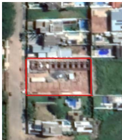
Figura 5 – Local da obra.
