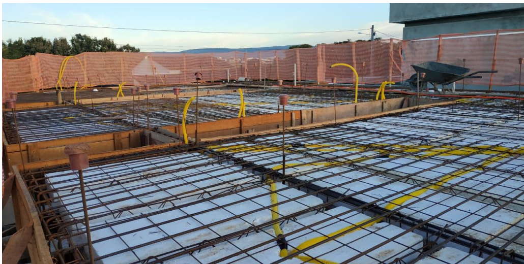
Figura 17 – Preparação da laje treliçada
