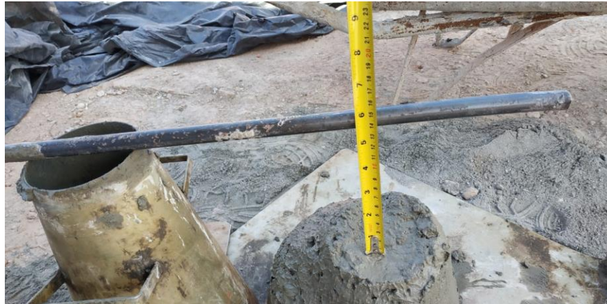
Figura 12 – Detalhe do abatimento do concreto
