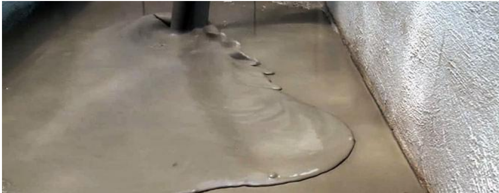
Figura 1: Espalhamento da argamassa autonivelante Fonte: AECWEB.
