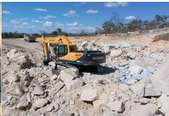
Figura 02: Desmonte de rochas. Fonte: Dos autores, 2018.
