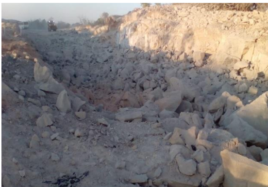
Figura 01: Desmonte de rochas. Fonte: Dos autores, 2018.
