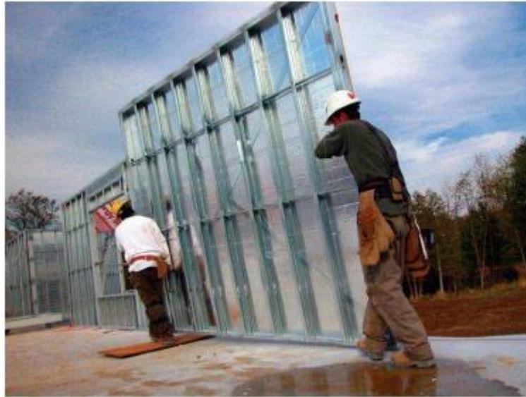
Figura 5 - Pré-fabricação de painéis e montagem no local (método por painéis)
