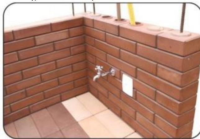
Figura 3 – Instalação Hidráulica e Elétrica
