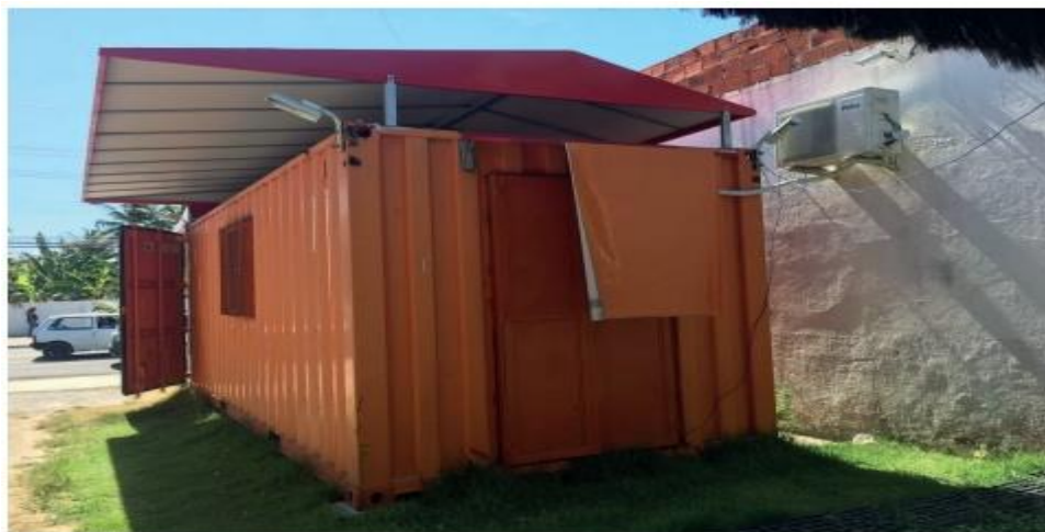
Figura 8 – Vista dos Fundos da Loja de Xerox feita em um container próximo ao Centro Universitário Tiradentes
