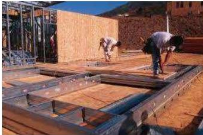
Figura 4 - Construção pelo método stick
