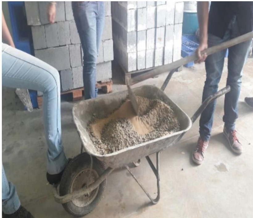
Figura 11 – Adição do agregado miúdo
