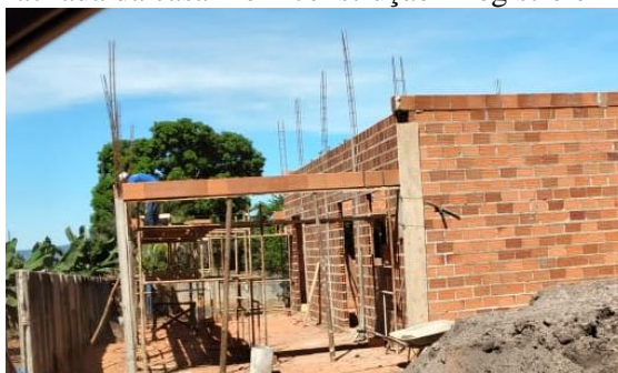
Figura 8 – Fachada da casa F em construção – registro em 27/04/2020.
