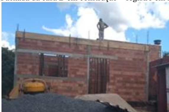
Figura 3 – Fachada da casa B em construção – registro em 22/01/2020.
