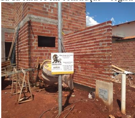
Figura 2 – Fachada da casa A em construção – registro em 13/01/2020.
