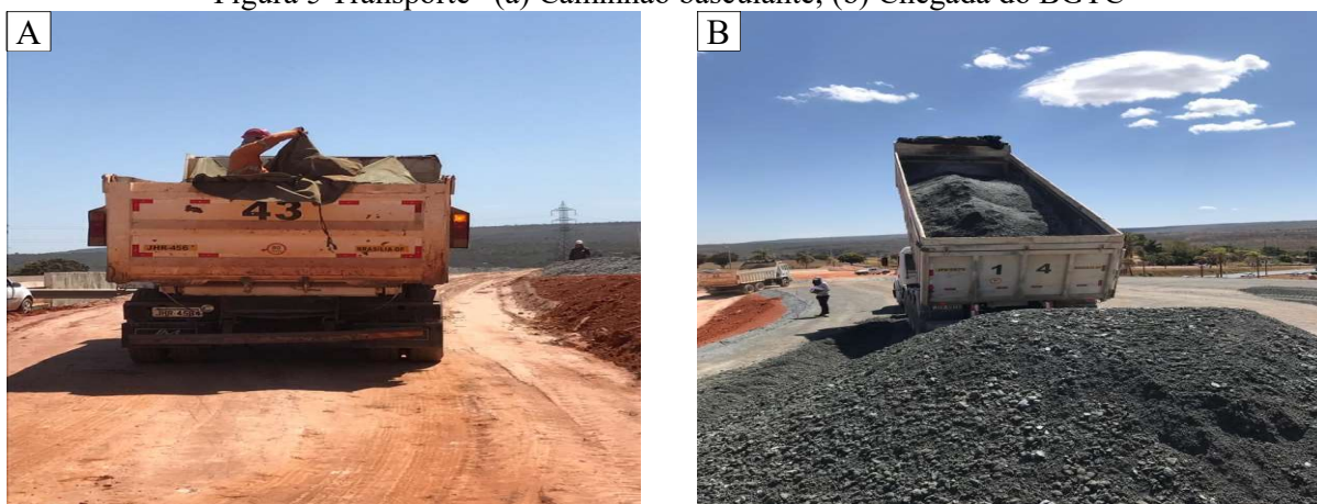
Figura 5 Transporte– (a) Caminhão basculante; (b) Chegada do BGTC
