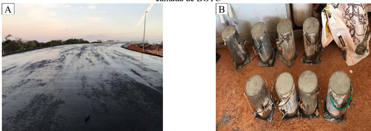
Figura 12 – Liberação da pista para tráfego: (a) Camada da base imprimada; (b) Amostras da camada de BGTC
