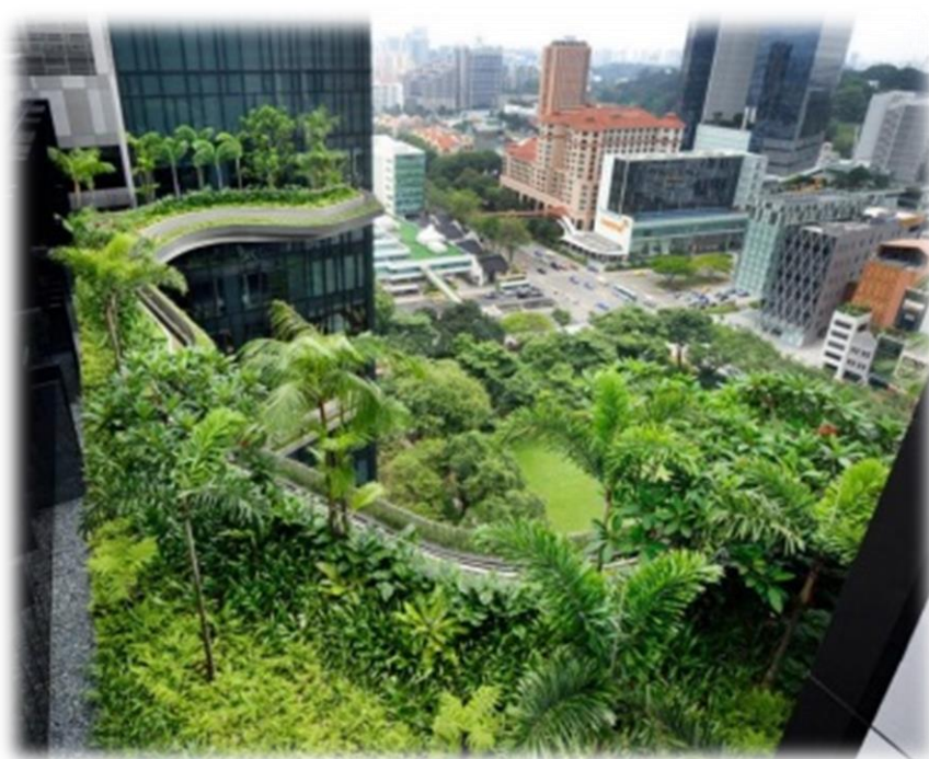
Figura 3: Telhado verde intensivo
