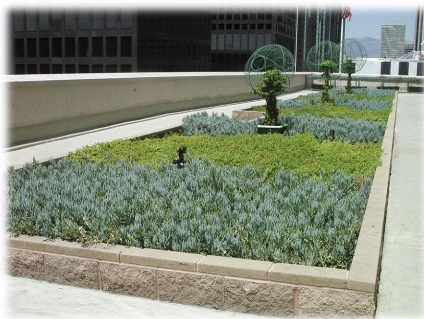
Figura 5: Telhado verde semi-intensiva
