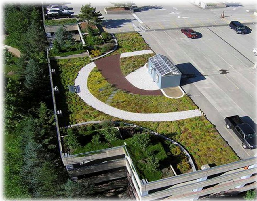
Figura 4: Telhado verde extensivo
