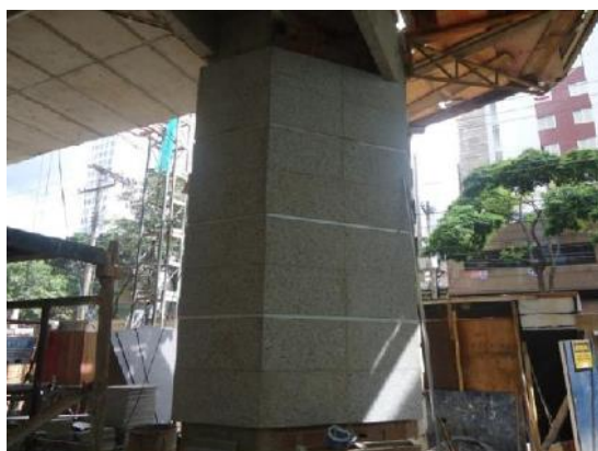
Figura 07 – Pilar revestido de granito,
