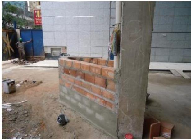
Figura 06 – Pilar revestido com alvenaria.
