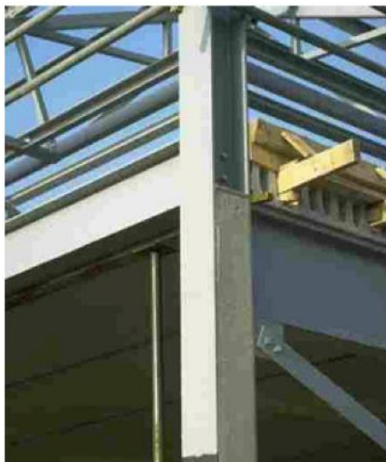
Figura. 3.3 Pilar de Aço parcialmente envolvido por concreto
