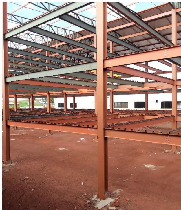
Figura 26 - Vigas e conectores de cisalhamento da estrutura do Edifício-exemplo
