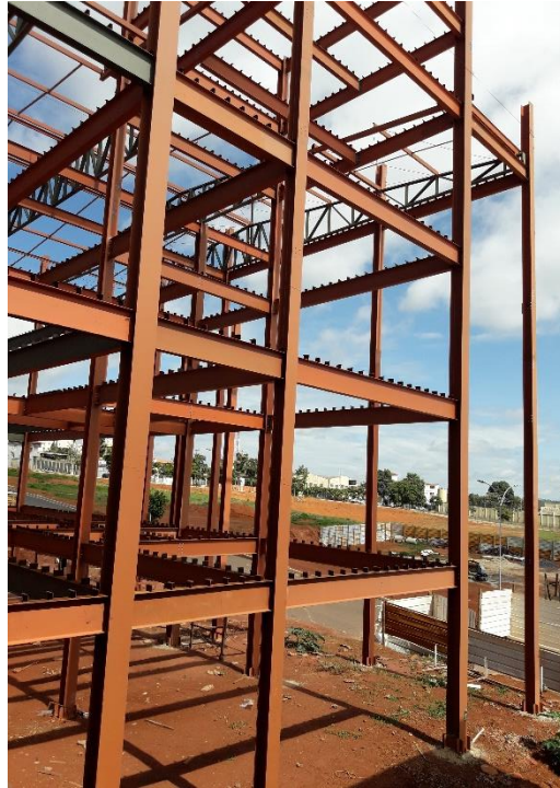
Figura 25 – Vigas e conectores de cisalhamento da estrutura do Edifício-exemplo
