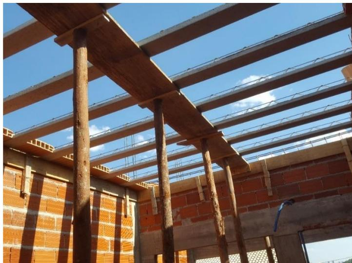
**Figura 23 - Armadura da laje.**
