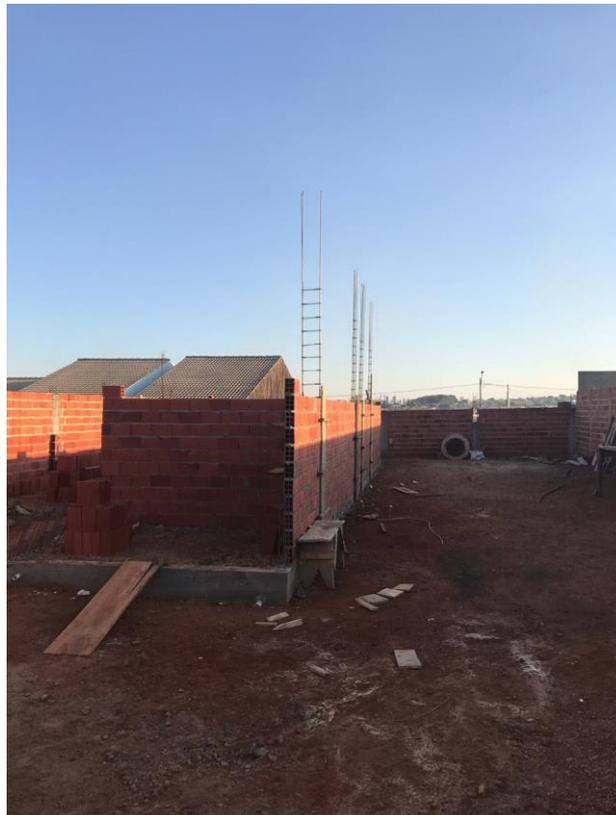
Com as paredes em meia altura a atenção foi voltada aos pilares terminando a montagem das formas e armaduras e sendo feita a concretagem subseqüentemente, depois foi feita a segunda parte da alvenaria seguindo os mesmos passos da primeira etapa.
