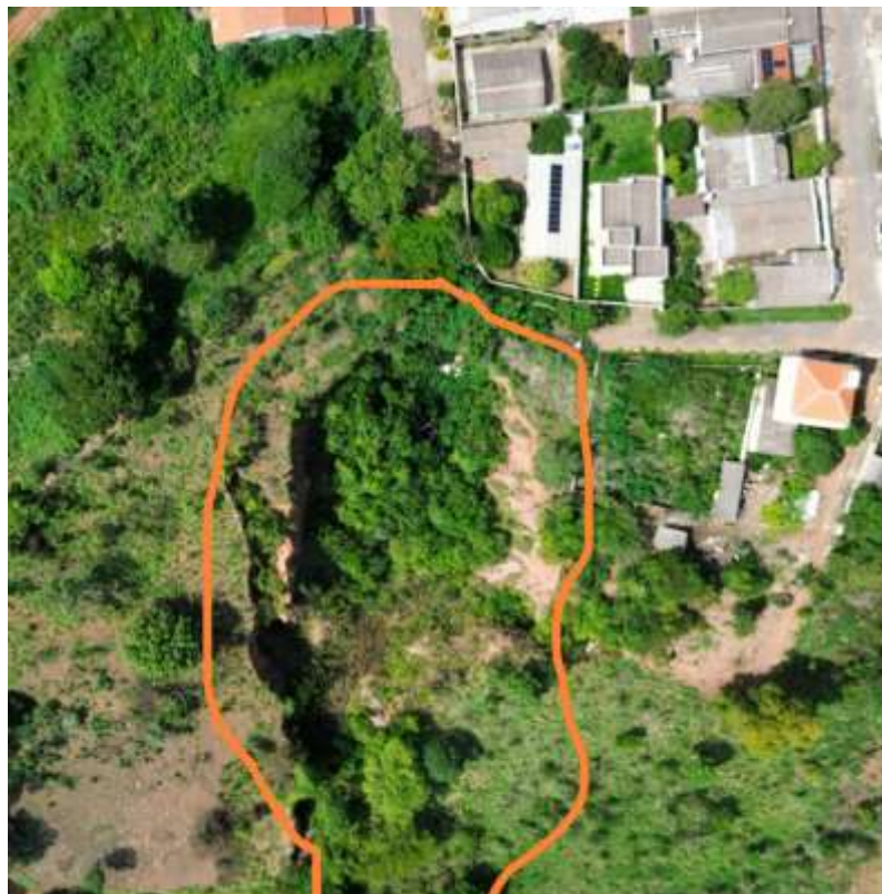
FIGURA 6: Erosão situada próxima à Escola Mun. Sebastiana Maria de Jesus
