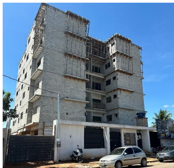
Figura 4 - Fachada da Edificação
