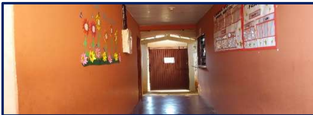
Figura 3: Entrada estreita, piso não adequado da escola F.
