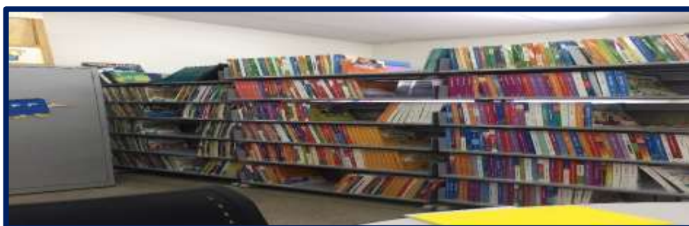
Figura 38: Prateleiras em biblioteca com altura superior à indicada pela norma.
