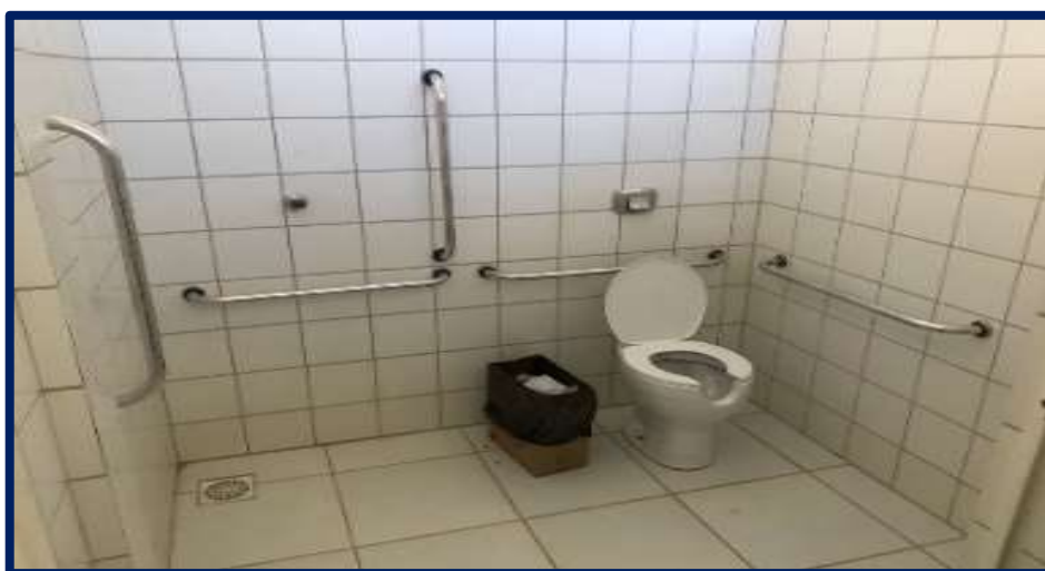
Figura 44: Sanitários com adaptação
