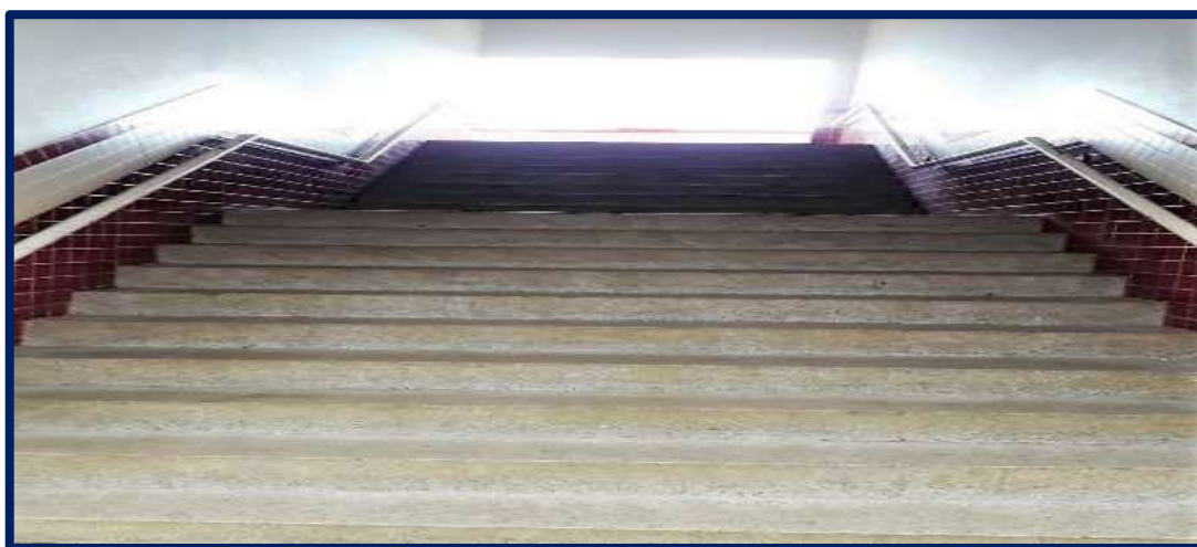
Figura 29: Escada com degraus sem borda e sem cores.
