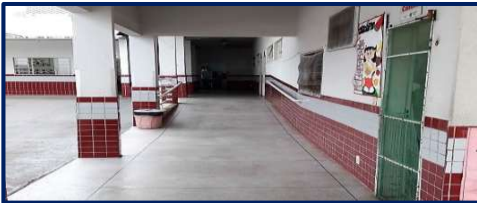
Figura 25: Corredores com obstáculos sem sinalização.
