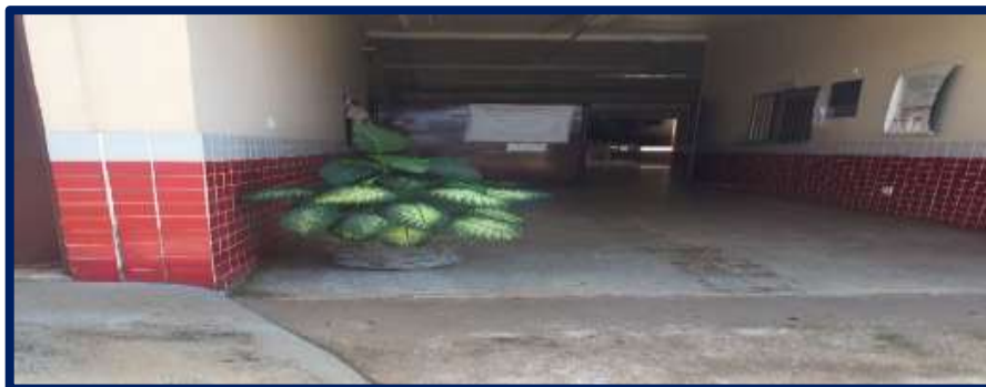
Figura 8: Vaso de planta na entrada da escola D, sem sinalização.
