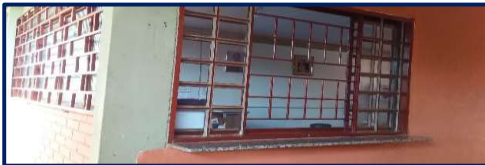
Figura 18: Balcão de atendimento em janela.
